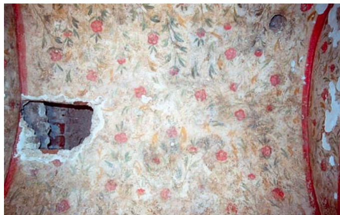
Abb. 2: Les peintures murales dans la voûte
